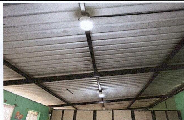
Foto 3: Mejoramiento de sistema eléctrico 100%
