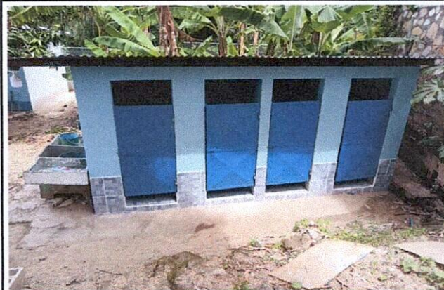
Foto 4: Mejoramiento de baños al 100%
