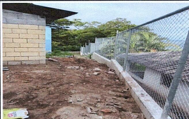
Foto 2: Mejoramiento de muro de contención 100%
