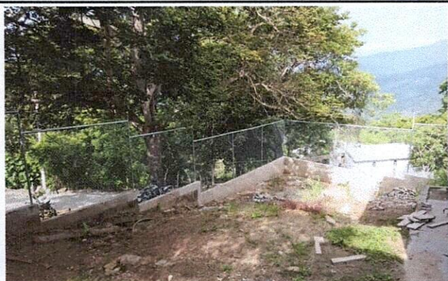
Foto 1: Mejoramiento de muro de contención 100%
